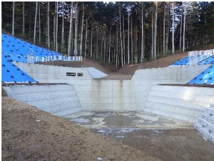
真栄川砂防工事（補正）
