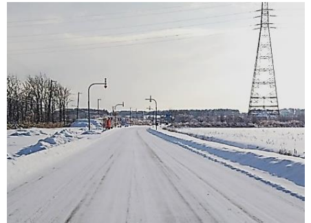
江別恵庭線総B6地方道工事
