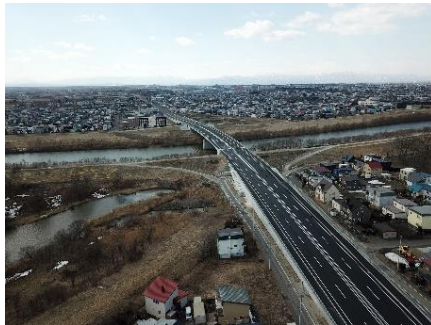
3・3・304南大通交付金（道路工）工事2工区
